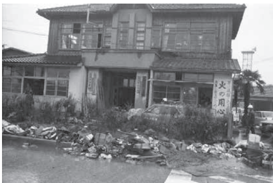
水が引いた後の消防署の様子
