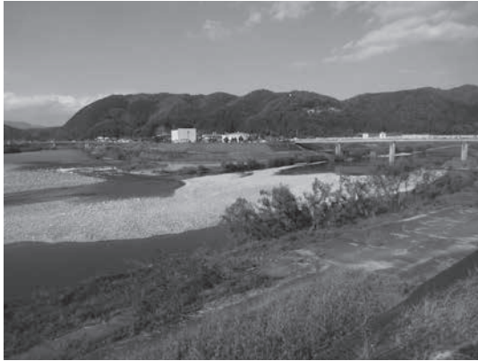
十日市側の堤防から、左に旭橋 右に馬洗川にかかる水道橋
